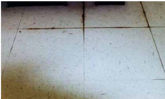
Feuchtigkeit und hoher pH-Wert lösen Kleber auf...
